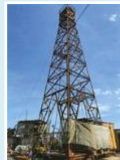
▲ボーリング・試掘坑による地質・断層調査
