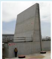
▲津波対策の例／防潮堤の建設
