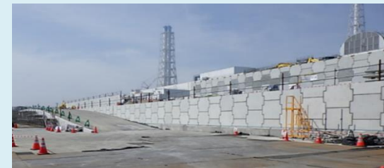
日本海溝津波防潮堤
